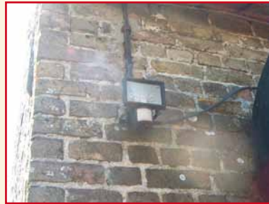
Figuur 32: Vrije toegang tot brandstoffen kan een hulpmiddel zijn bij brandstichting (links) terwijl een verlichting met bewegingmelder de toegang door vreemden zal melden (rechts)
